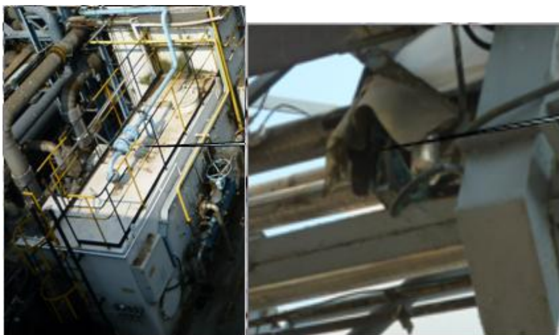
图 8 珠江气体有限公司受雷击损坏的设备
